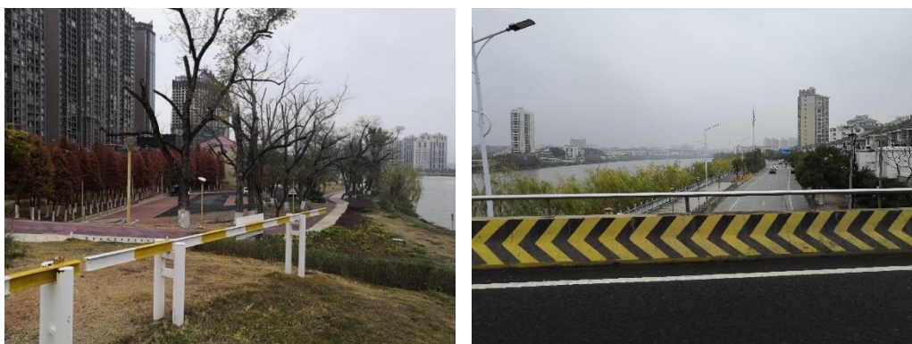
图 6.6-3 兴国县城防洪工程现状图（土堤段、挡墙段）
